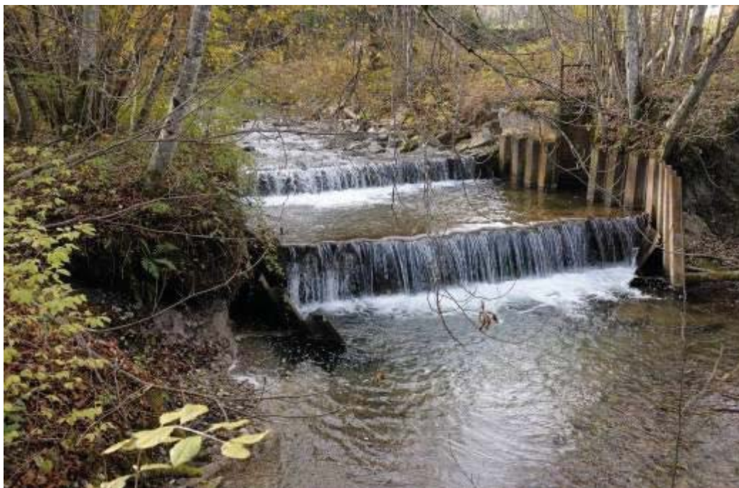
Bild 33: Beeinträchtigung der Lebensstätte von Groppe [1163] und Biber [1337] an der Eschach südlich von Schmidfelden durch Sohlschwelen nicht passierbare Flussabschnitte. J. Grom, 31.10.2009
